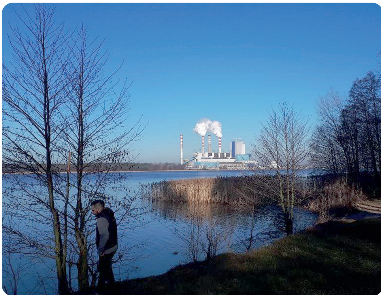
Elektrownia Pątnów, fot. Miłostawa Stępień
